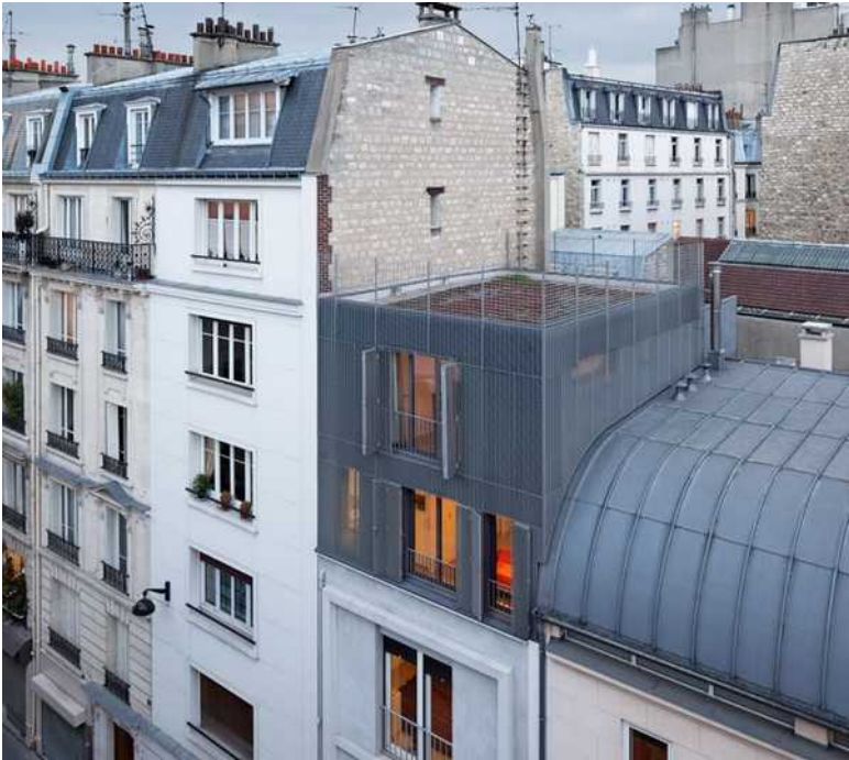
Rehausse d'immeuble d'habitation
